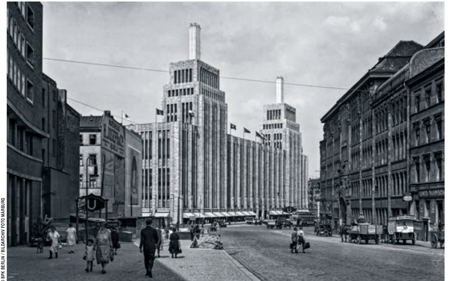
ABB. 7: BLICK VON DER HERMANNSTRASSE AUF DAS ART-DECO-WARENHAUS KARSTADT DES ARCHitekten PHILIPP SCHAEFER, HERMANNPLATZ, 1929
